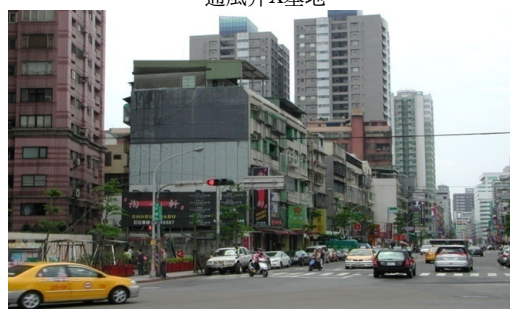
出入口2與通風井Y基地
