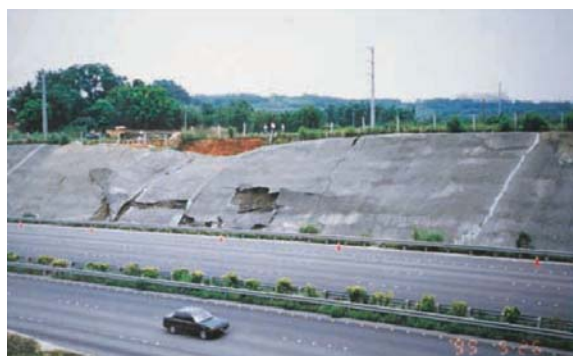
(a) 施工階段 (國工局, 1995)
