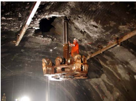
圖四 2003年2月8日一號豎井排氣井 RBM 擴孔鑽頭安裝 (張文城提供)
