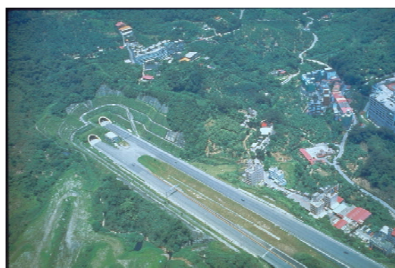
圖一 北二高福德隧道北口 (張文城提供)
