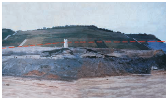
(a) 施工階段 (國工局)
