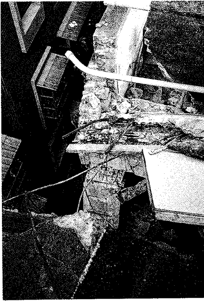
照片十五 重新路三段 60 巷 1 號之頂樓女兒牆在塌陷時因撞擊重新路三段 62 號樓頂而崩碎
