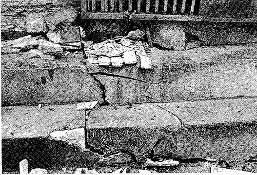
照片十八 中正南路 8 巷 6 號門前石階因 8 號(右側)下陷而折斷
