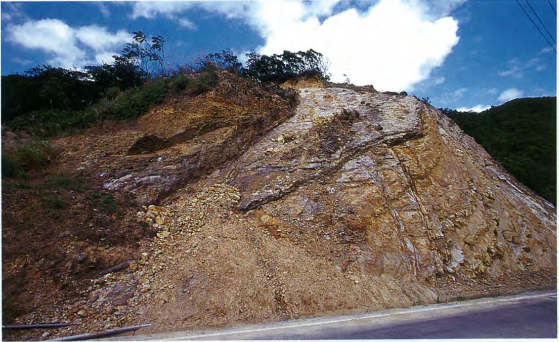
照片一 小規模順向坡破壞，汐萬路勸湖附近
