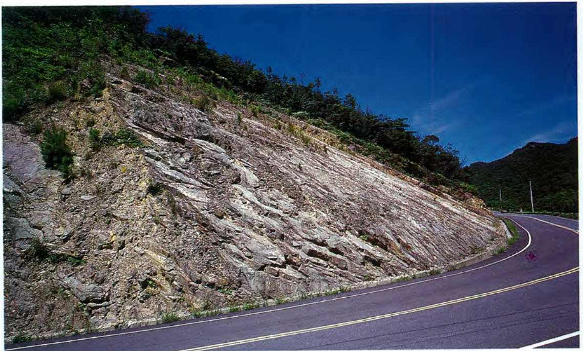
照片十四 照片十順向坡面的局部，示一些薄岩層自由端出露的情形
