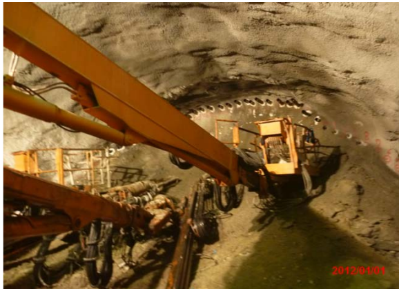
圖十六 新山里隧道施工中前進探查鑽孔
