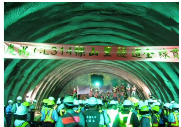
圖十八 101年3月15日山里隧道全線貫通
