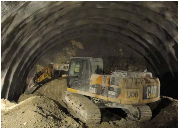
圖十五 新山里隧道機械鑽掘開挖
