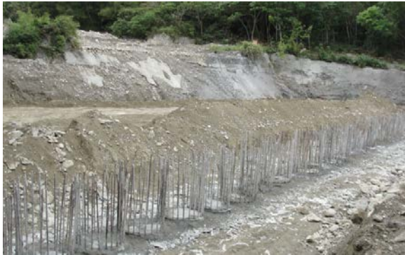
圖十四 隧道過河段固床工之全套管基樁
