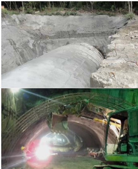
圖十 山里隧道A工區過河段頂蓋工法施工
