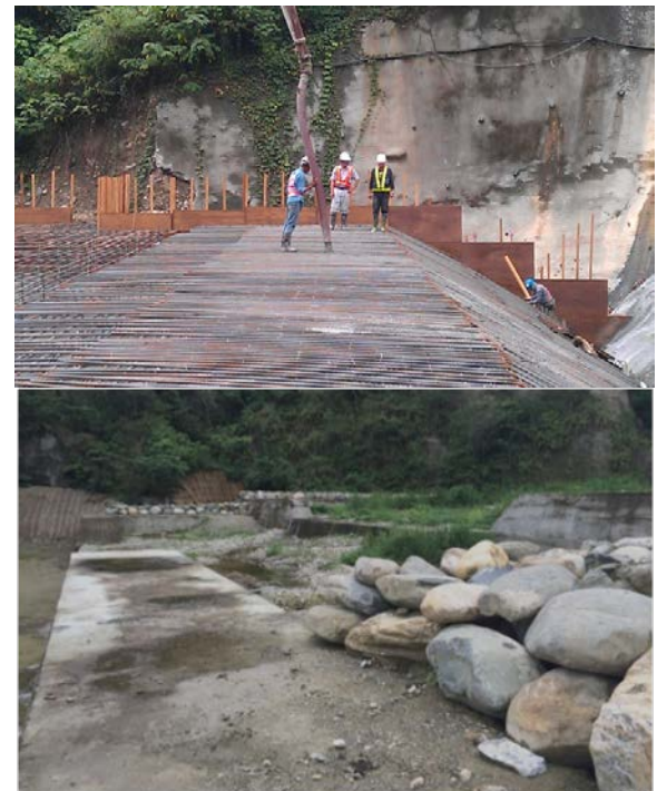
圖十三 隧道過河段固床工施工及完成情形
