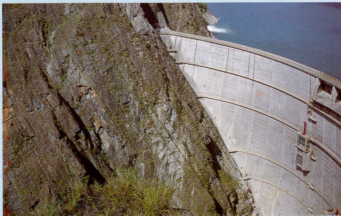
照片六 德基拱壩右壩座之砂質板岩劈理與節理
