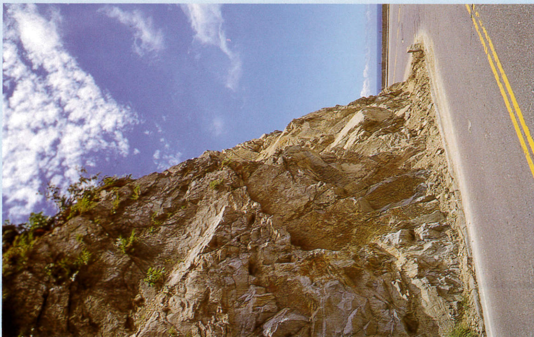
照片十六 片麻岩懸崖，蘇花公路上邊坡
