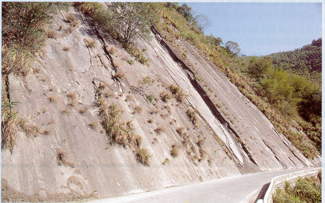
照片二 北橫公路板岩順向坡
