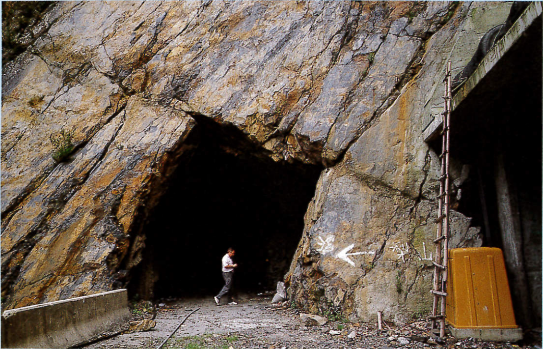
照片十 馬陵三號隧道東口之解壓節理，近照
