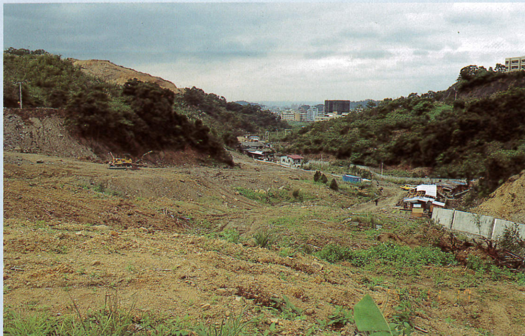
照片四 待老坑坑谷之中末段，北二高部分工程施工中(80. 11. 17 攝)
