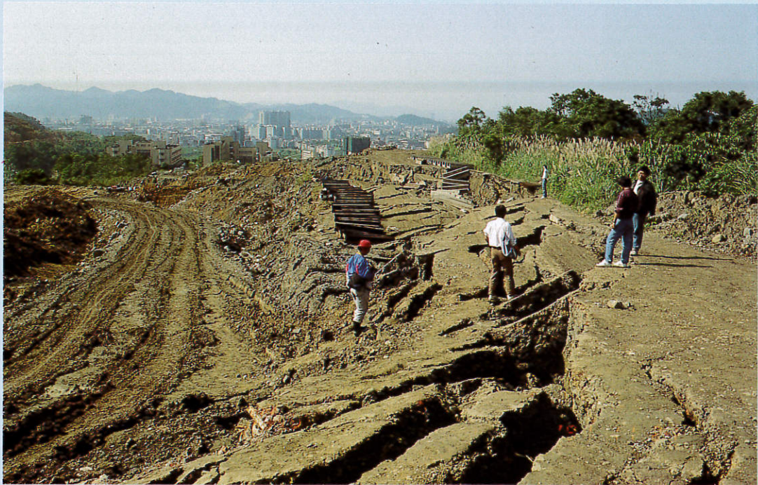
照片十 政大原環山道路高線路段地表開裂坍塌之情形(80. 11. 21 攝)
