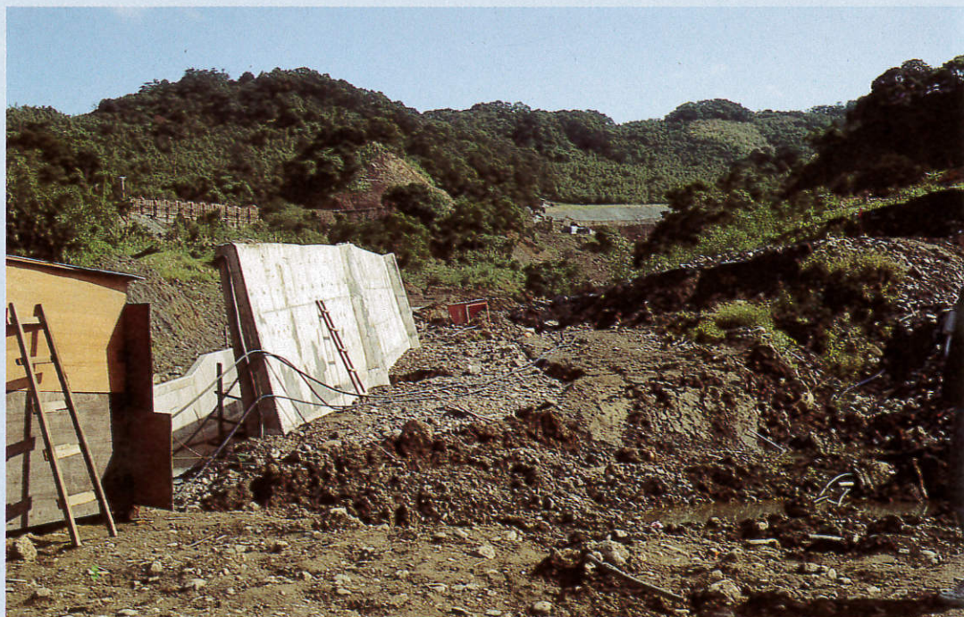
照片五 地滑區坡趾處之北二高排水箱涵歪斜，坡趾地表隆起(80 年 11 月中攝)
