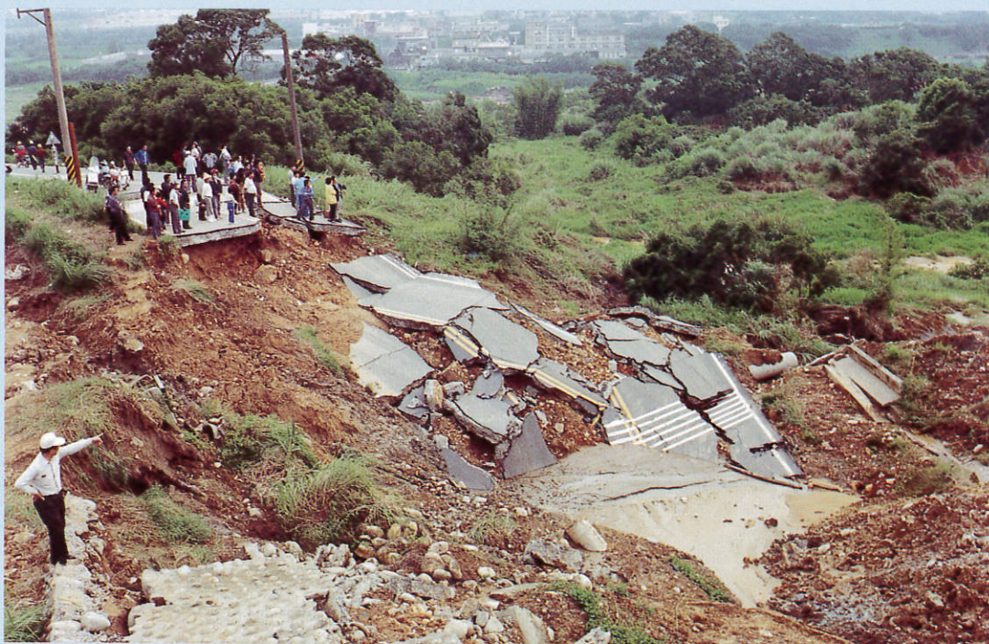
照片五 坍方災害舉例之一，道路中斷
