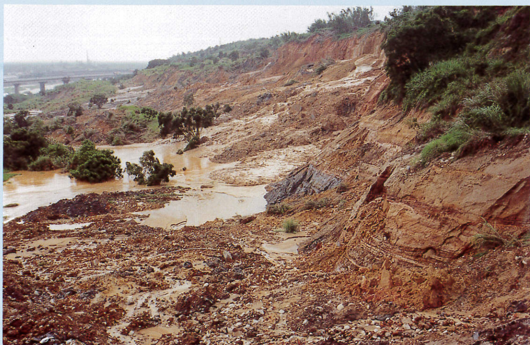
照片二 坍方四天後現場積水及泥濘之情況
