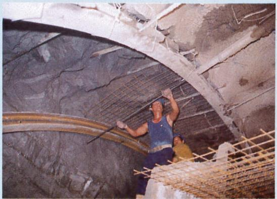
照片十七 主隧道工作面鋪設鋼絲網
