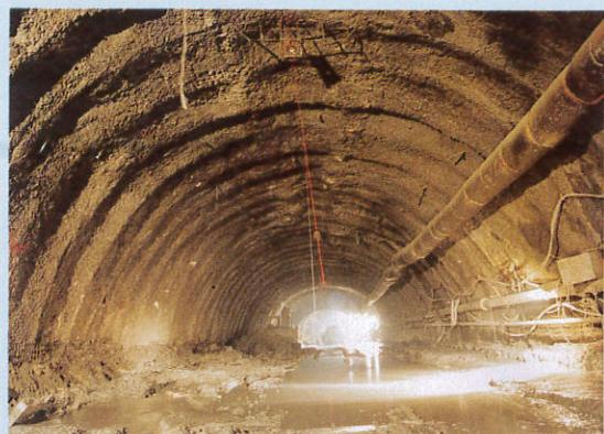
照片十五 主隧道工作面使用雷射儀測設
