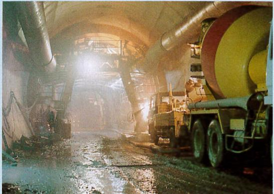
照片十九 主隧道全段面襯砌完成面
