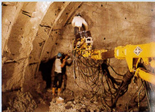
照片十 通風斜坑鑽設炸藥孔
