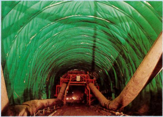
照片十八 主隧道工作面防水膜鋪設
