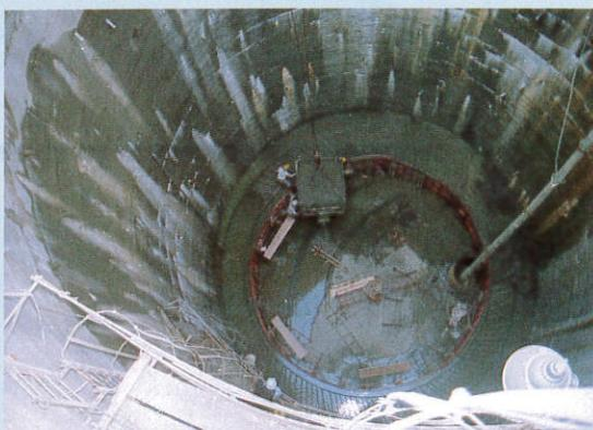
照片六 東側工作井底部襯砌混凝土
