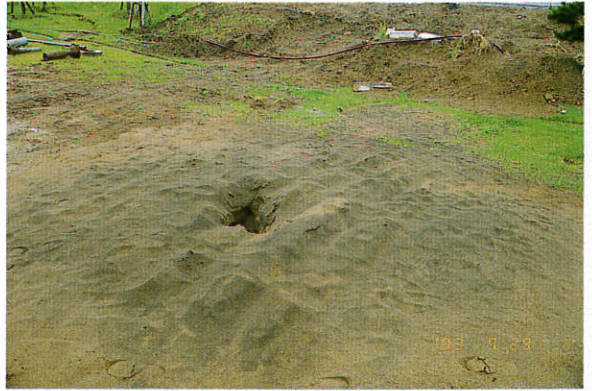
照片四 土壤液化之噴砂孔
