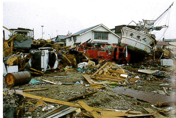
照片十 奧尻島南端青苗村海嘯災害
