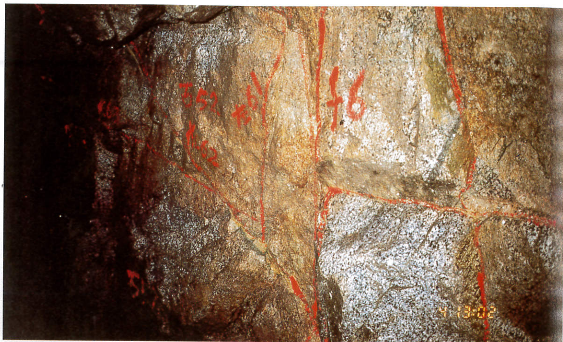
照片九 平洞岩壁所顯示之斷層及裂縫
