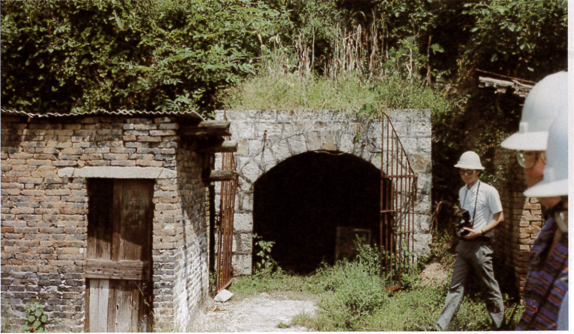
照片七 平洞（探查橫坑）洞口
