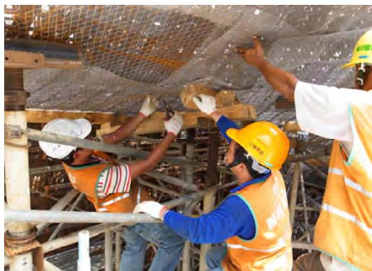
圖九 施工中鋪設金屬網外模
