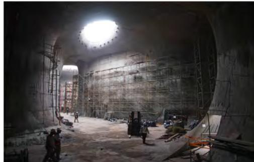
圖十二 施工中二樓前廳支撐架拆除
