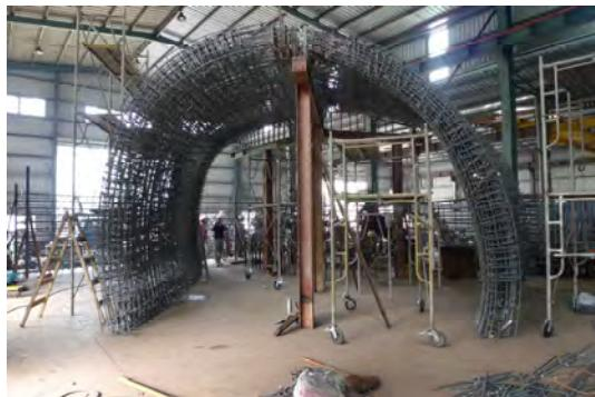
圖八 現場曲牆鋼筋綁紮
