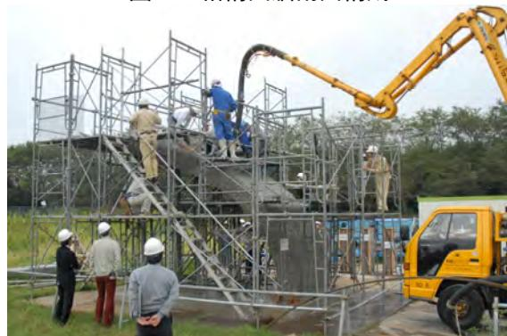
圖六 投標前設計單位在日本進行的實體模型試作
