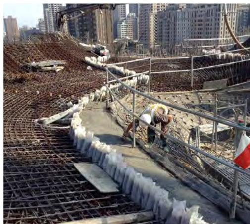
圖十 高流動混凝土澆置及隔離
