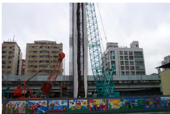
圖三 厚度 1.8 m 連續壁鋼筋籠吊放
