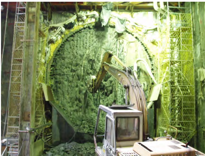
圖八 連續壁與隧道鏡面冷凍後破除
