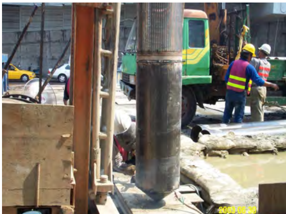
圖六 抽水管之濾水管下方安裝 1 m 長沉砂管
