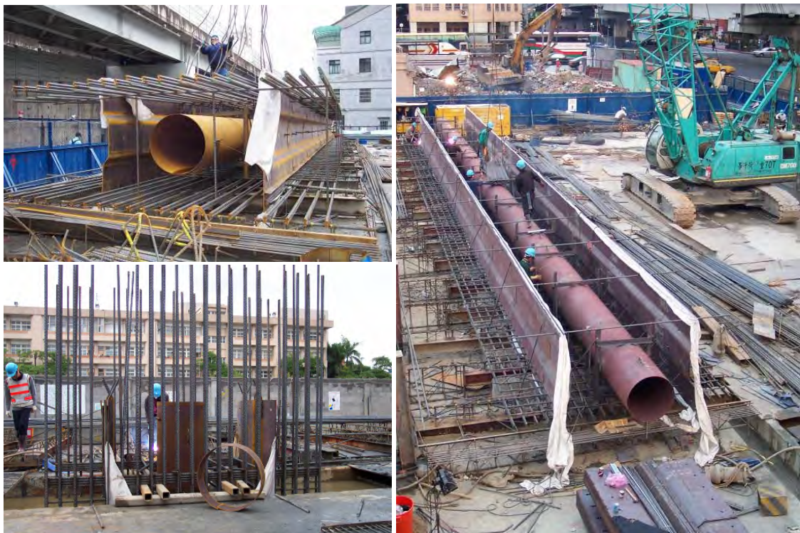
圖五 連續壁內預埋 1 m 直徑抽水管
