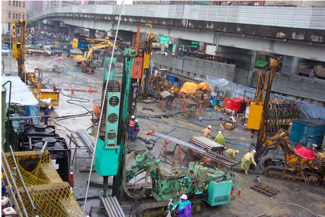
圖四 全面封底灌漿施工
