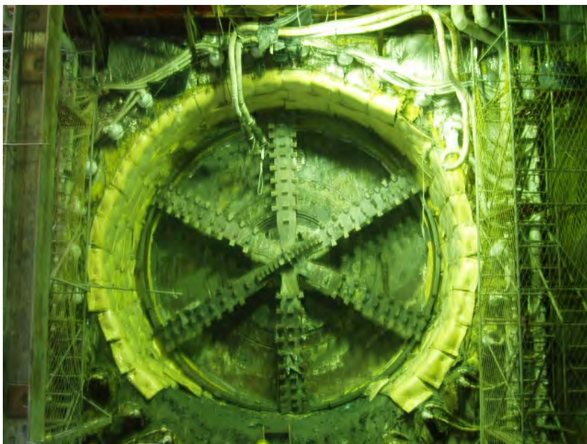
圖九 鏡面冷凍破除後潛盾機露出
