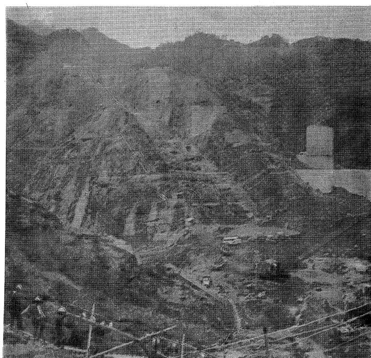
圖10.7(b) 翡翠壩址開挖，照片重點：河床及右岸
