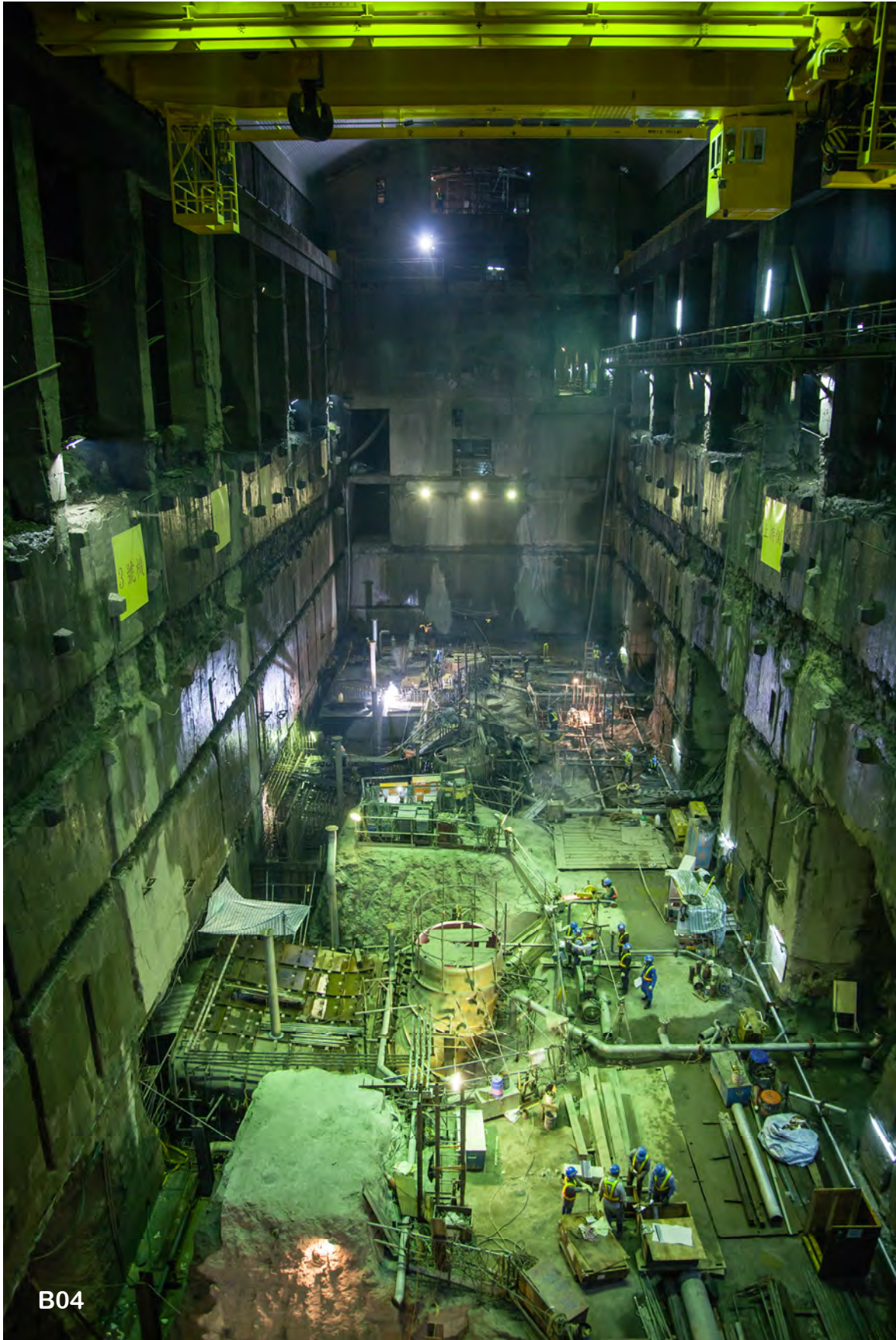
發電機組及機座整個拆除後地下電廠的巨大空間一覽無遺，對比下方微小而忙碌的工作人員，顯示出工程的浩大
