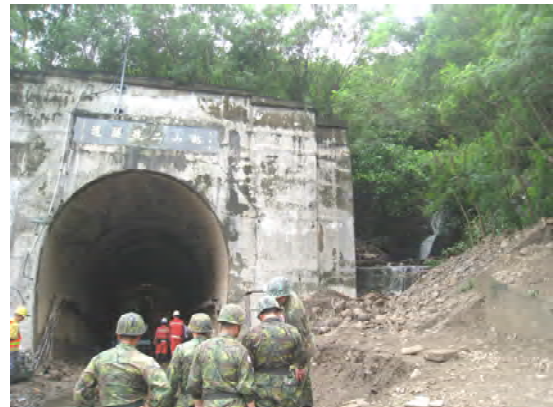
圖二 枋山二號隧道東口脫軌事件次日之搶修過程(李春明先生)
