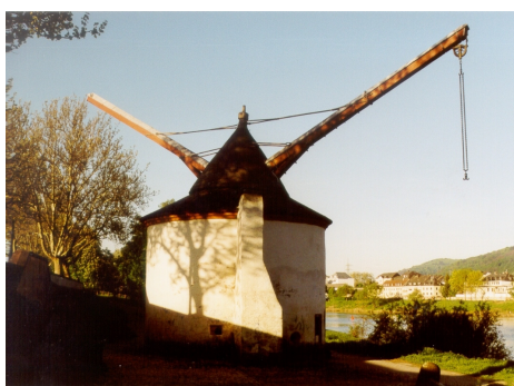
圖四 1413年德國特里爾內港的塔吊 (引自維基百科~起重機)
