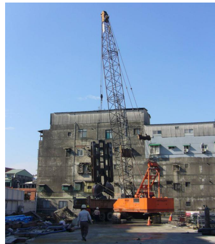
圖八 ML工法履帶起重機形式
