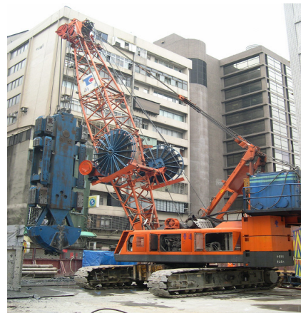
圖九 MHL工法履帶起重機形式-後方放置油壓動力箱
