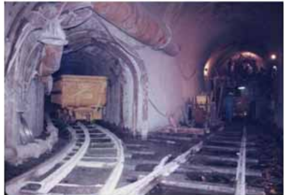
圖二十六 迂迴坑施工照片(東線鐵路拓寬工程處，1985)
