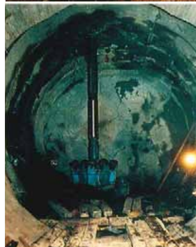
圖三十 南迴鐵路隧道豎坑之昇井工法示意圖(南迴鐵路工程處，1992)
