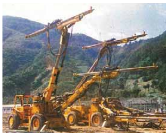
(b) 輪胎式鑽堡機(北迴鐵路工程處, 1981)
