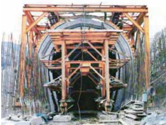
圖二十二 光復河底隧道施工照片(陳，2011)
