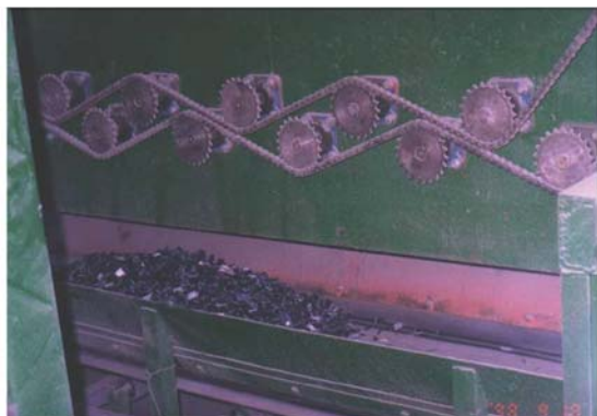
(e) 鋼纖維噴凝土
