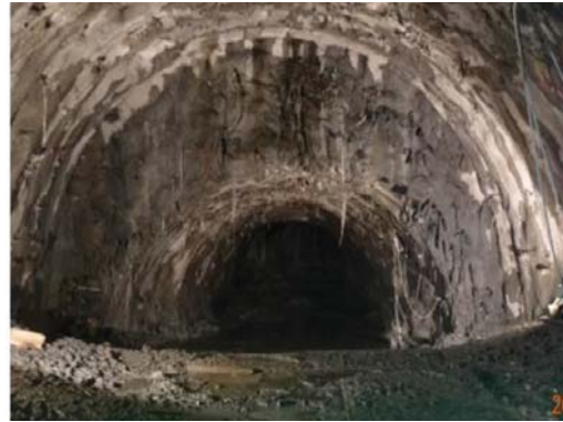
圖三十九 新自強隧道沉泥層中導坑工法(交通部鐵路改建工程局東部工程處, 2018)
