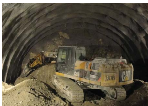
圖四十八 新山里隧道機械開挖(許等人, 2018)
