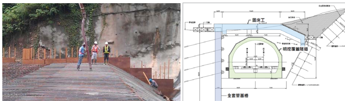
圖四十七 新山里隧道固床工(許等人, 2018)
