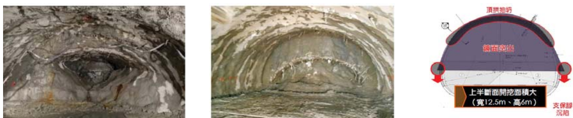
圖三十八 新自強隧道沉泥層區頂拱大量變形及遭遇困難示意圖(交通部鐵路改建工程局東部工程處，2018)
