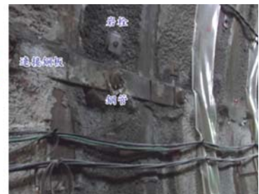
(b) 側壁補強鋼管
