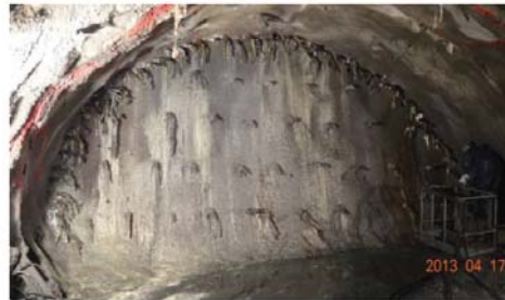
(a) 前進開挖面預加固工法
