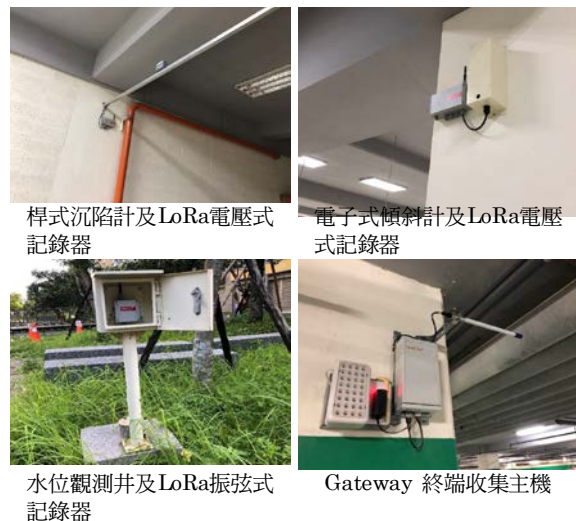
圖四 LoRa物聯網監測案例儀器設備安裝照片
