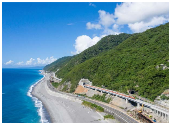
圖九 多良改線段切換通車情形
