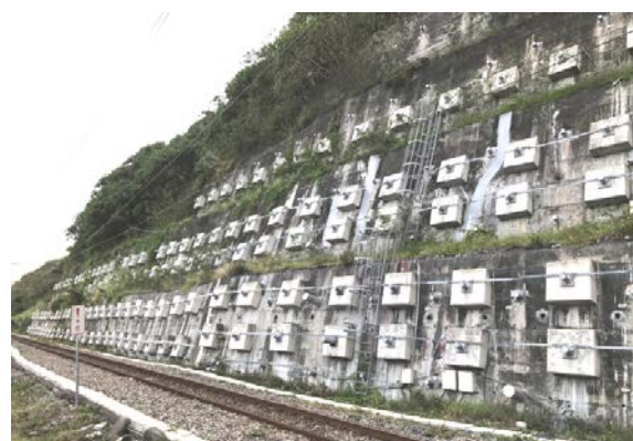
圖十三 富山邊坡補強後情形
