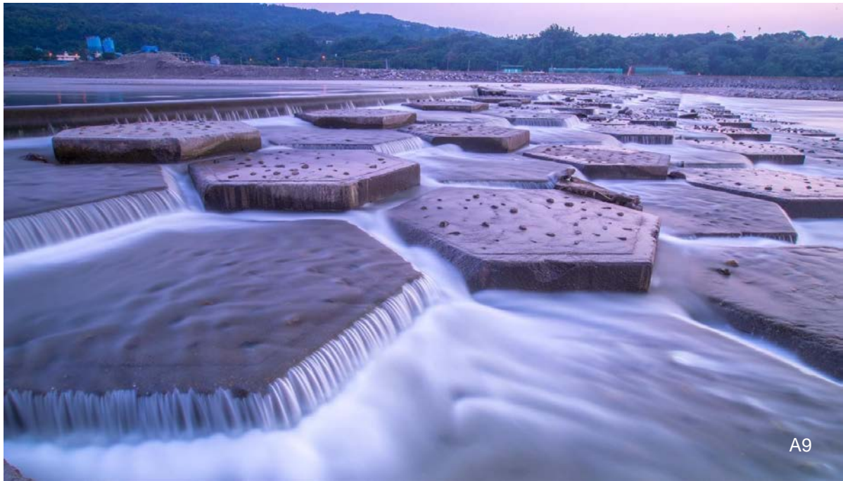
A9 引水設施工程/攔河堰、六角格框/山高而月小，水落而石出
