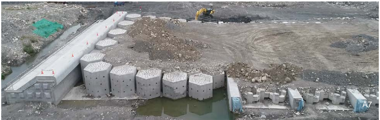
A7 引水設施工程/攔河堰、六角格框/水流自左向右流動，攔河堰採用低矮堰設計(堰頂高程同原河床面高程)，最大限度地降低對河川生態之影響，另堰頂高程採用漸變設計，於堰面營造多種流速及水深，可供魚類擇最適上溯路徑。六角格框為採用六角形設計之消能工，為國內首例，格框上下游落差 50cm，左右落差 25cm，於間格處可產生魚類迴游路徑，供魚類使用
