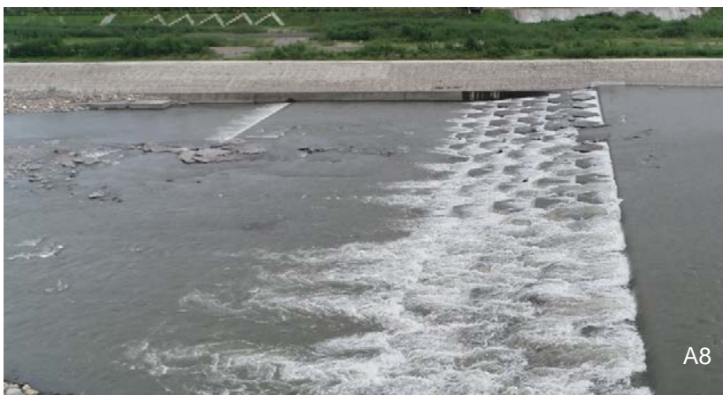
A8 引水設施工程/攔河堰、六角格框/堰面局部通水狀況，可見水深左高右低，不同的水深搭配不同的流速，供不同的魚種使用，大量的水花及水聲確保能吸引到魚類
