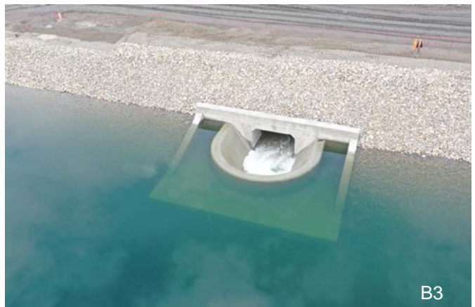
B3 人工湖工程/側溢流堰/圖為側溢流堰運作狀況，颱風或豪雨時，超量的水體將自溢流堰排回烏溪河道中，不需人為操作，確保湖區安全
