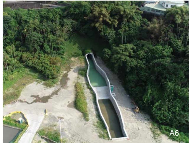
A6 引水設施工程/巴歇爾量水槽/清水出隧道口經巴歇爾量水槽量測流量後，往湖區輸送。本計畫採用 20 英尺之巴歇爾量水槽，量水範圍介於 0.31~37.97cms，水頭範圍介於 0.09~1.83 公尺，為國內少見之大型量水槽
