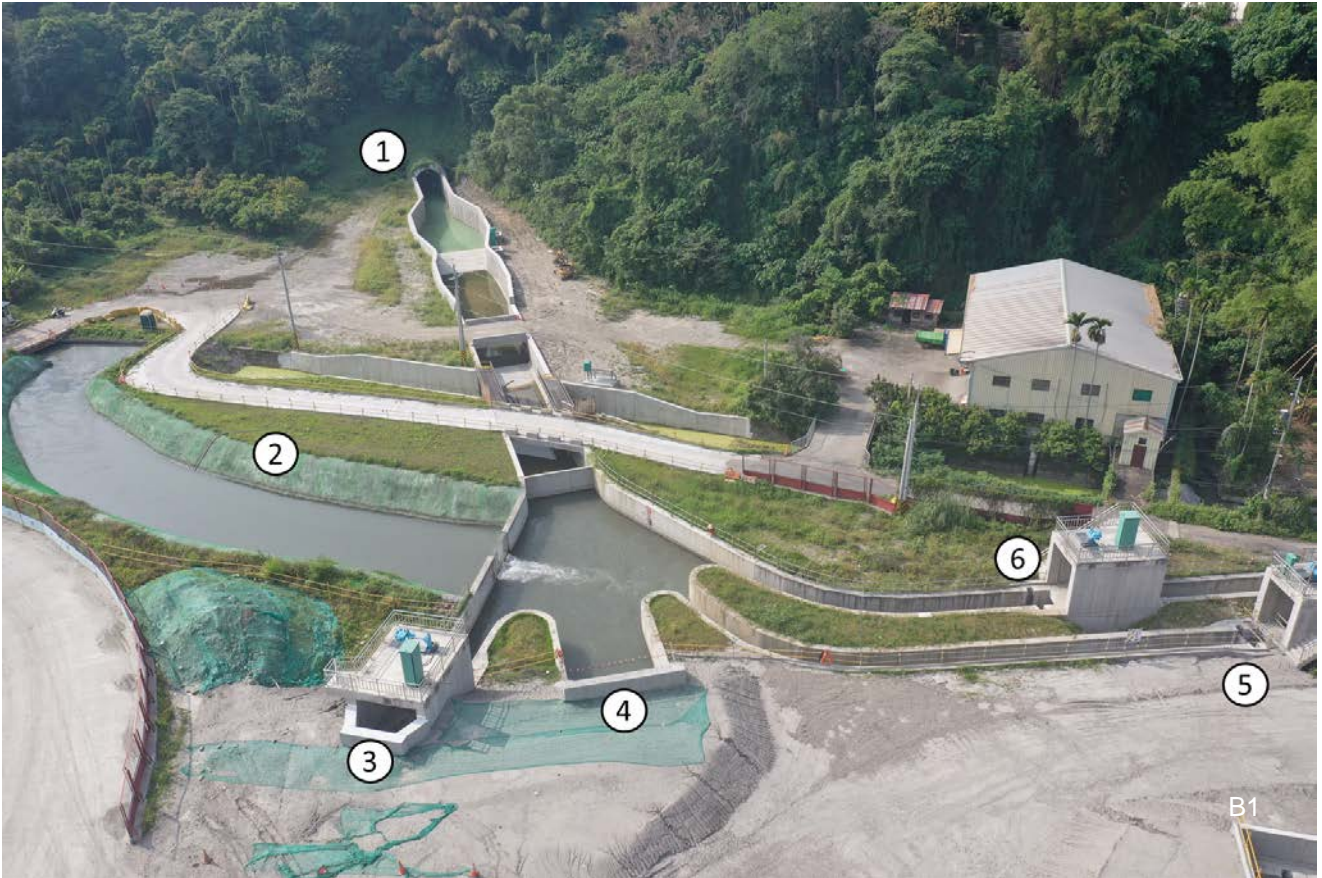
B1 人工湖工程/分水工/水流自上向下流，自引水設施引入之清水，出隧道後經巴歇爾量水槽量測流量後，進入湖區分水工，圖中①為引水設施隧道出口，為完工後使用。②為備援引水，自北投新圳取水口引入原水，於後續引水設施歲修時使用。③為供水阿罩霧圳。④為引水進入湖區至各湖區入流工。⑤為供水茄荖媽助圳，⑥為供水北投新圳
