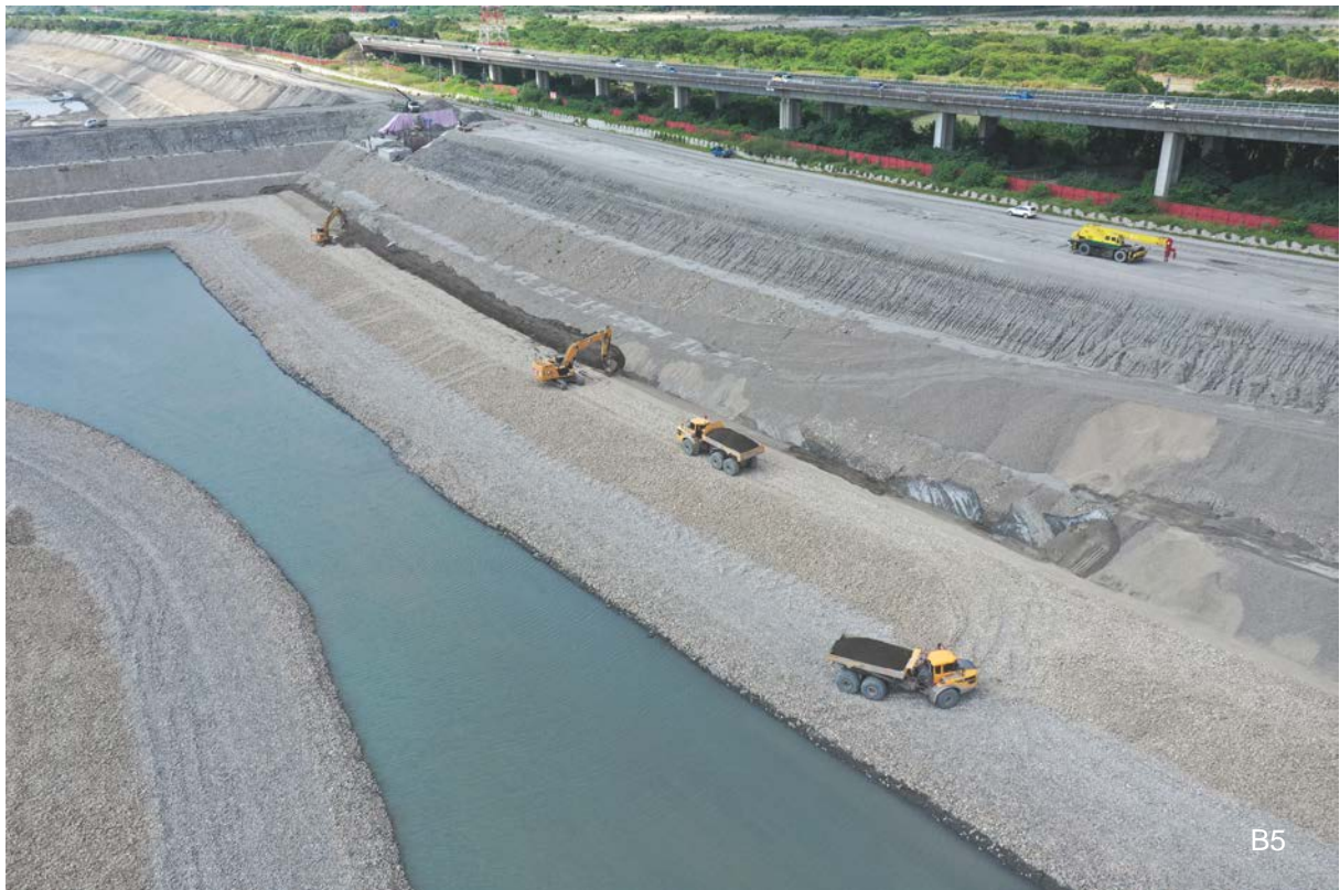
B5 人工湖工程/濾層填築/圍堤填築順序為開挖至岩盤後，由下往上逐層填築，圖中可見湖底已填築至拋石層，再往上為濾層填築，圖中最上層為原始岩盤。另為克服施工過程中之嚴峻地形，施工廠商引進全新之鉸接式牽引車，用以運輸土石，可有效加速土方運輸速度及因應各種施工過程中之困難地形
