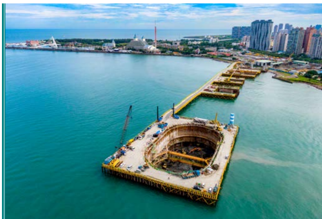
C7 P120 主橋墩柱以系統鋼模組立
