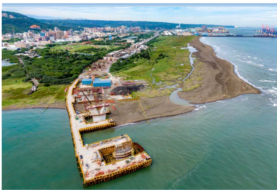
C13 遠處八里端銜接61號快速道路引道已接近完成
