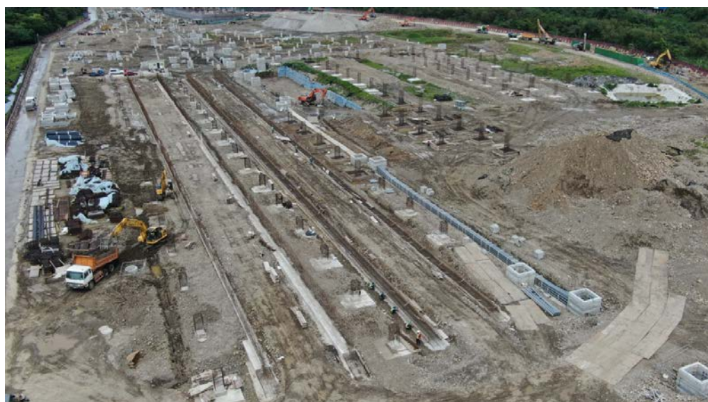
C8 三鶯機廠目前施工現況。照片上方為提供捷運車輛維修調度之扇形區，中間為駐車廠，右側為主維修廠。各項供電及系統機電管線則設計以共同管道方式配置，以利後續維修管理
