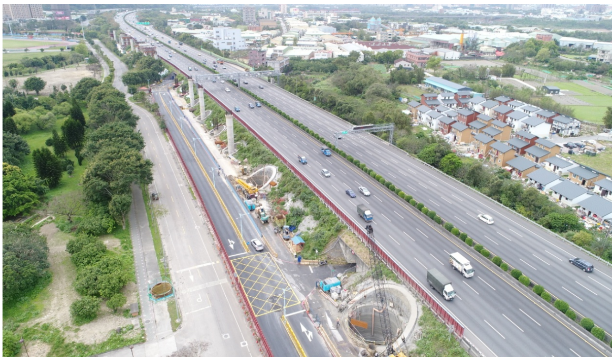
C3 三峽區捷運預定路線緊鄰營運中之國道三號高速公路。受限於有限路權及狹小施工空間，此路段捷運三鶯線高架橋墩柱規劃座落於國道三號邊坡上，未來並將配合高速公路單側拓寬一個線道
