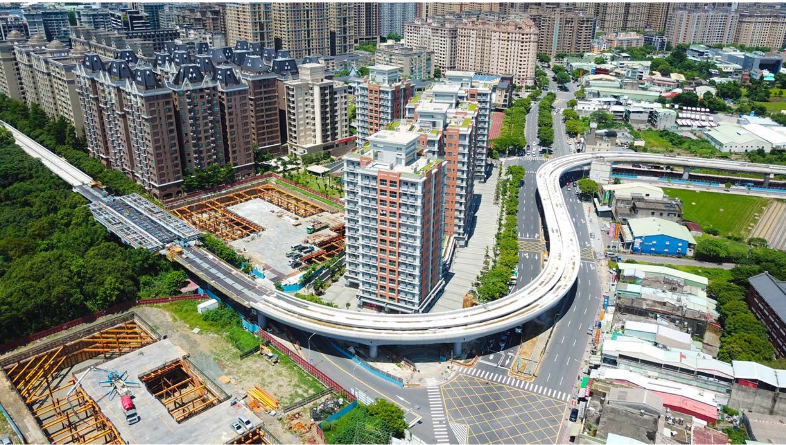
C1 LB06 車站及高架段施工現況空拍
