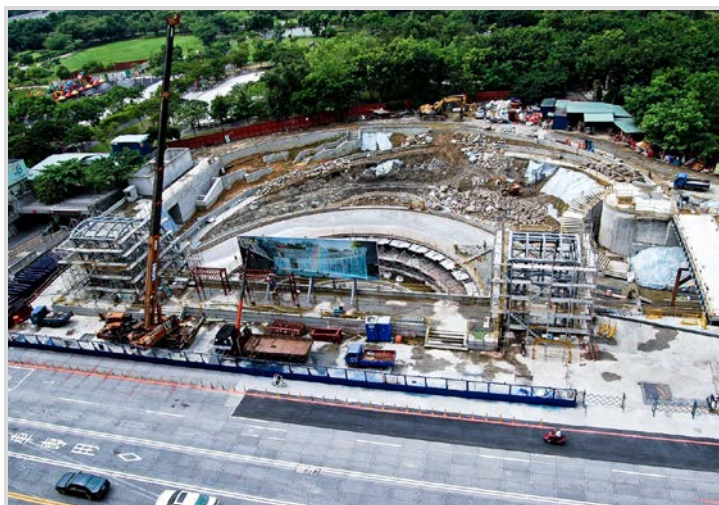
C1 大安森林公園站善用車站緊鄰公園的地理特質，將原設計之車站位置由道路中心向公園南移 9 m，使車站與公園結合。下凹庭園為由大安森林公園往車站方向斜面向下開挖至車站之穿堂層南側，並配合設置光塔及光廊，將公園的陽光及綠意引進地下車站，提供在地居民及遊客休憩使用，近期更成為北捷與咖啡店結合新據點
