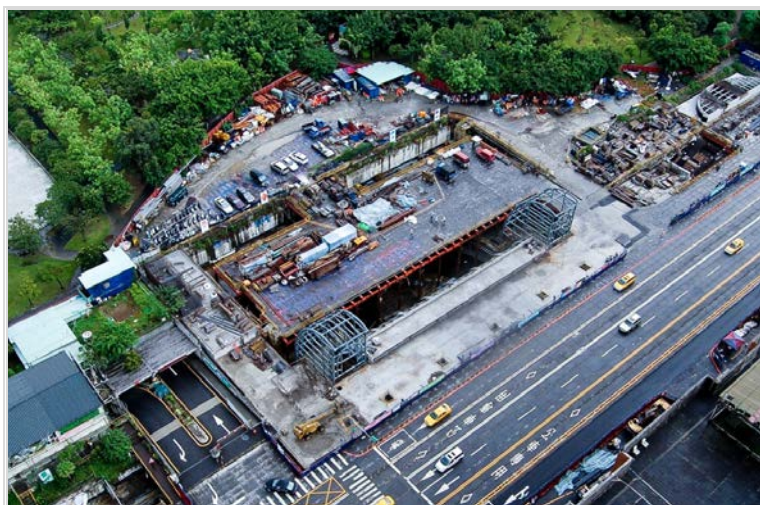
C1 大安森林公園站善用車站緊鄰公園的地理特質，將原設計之車站位置由道路中心向公園南移 9 m，使車站與公園結合。下凹庭園為由大安森林公園往車站方向斜面向下開挖至車站之穿堂層南側，並配合設置光塔及光廊，將公園的陽光及綠意引進地下車站，提供在地居民及遊客休憩使用，近期更成為北捷與咖啡店結合新據點
