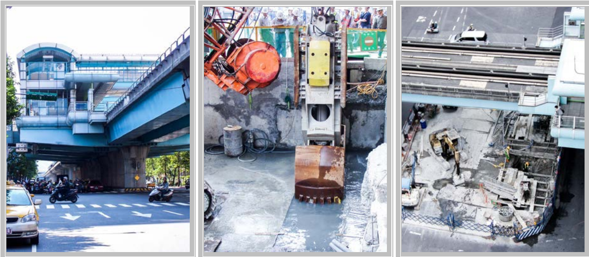
C2 由大安森林公園站以潛盾隧道往東續行即抵大安站，大安站位於信義路及復興南路交叉口，且部分站體開挖位於文湖線高架橋下(左)，淨空高度僅5.25 m，連續壁需採限高工法施作，且因該路口車流量大，施工場地亦受交通維持之限制(中)。限高段連續壁厚度1.2 m、深度58 m，經降挖地表2.55m 並配合特製的矮掘機(右)進行連續壁槽溝抓掘，以極有限的施工作業空間，進行深開挖施作
