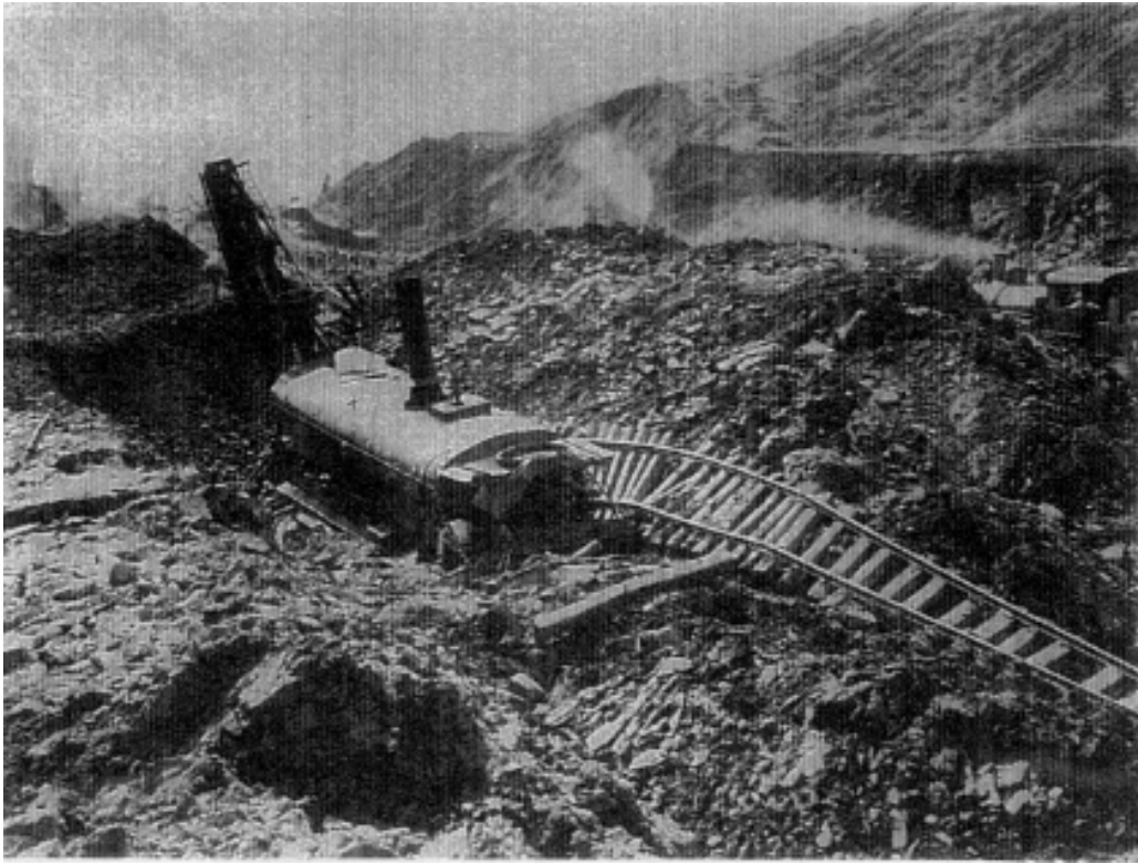
照片四 Gaillard Cut發生於1913年2月6日的Powderhouse滑動，照片中央可見蒸氣 罐及鐵軌被破壞的情形(Turner and Schuster, 1996)
