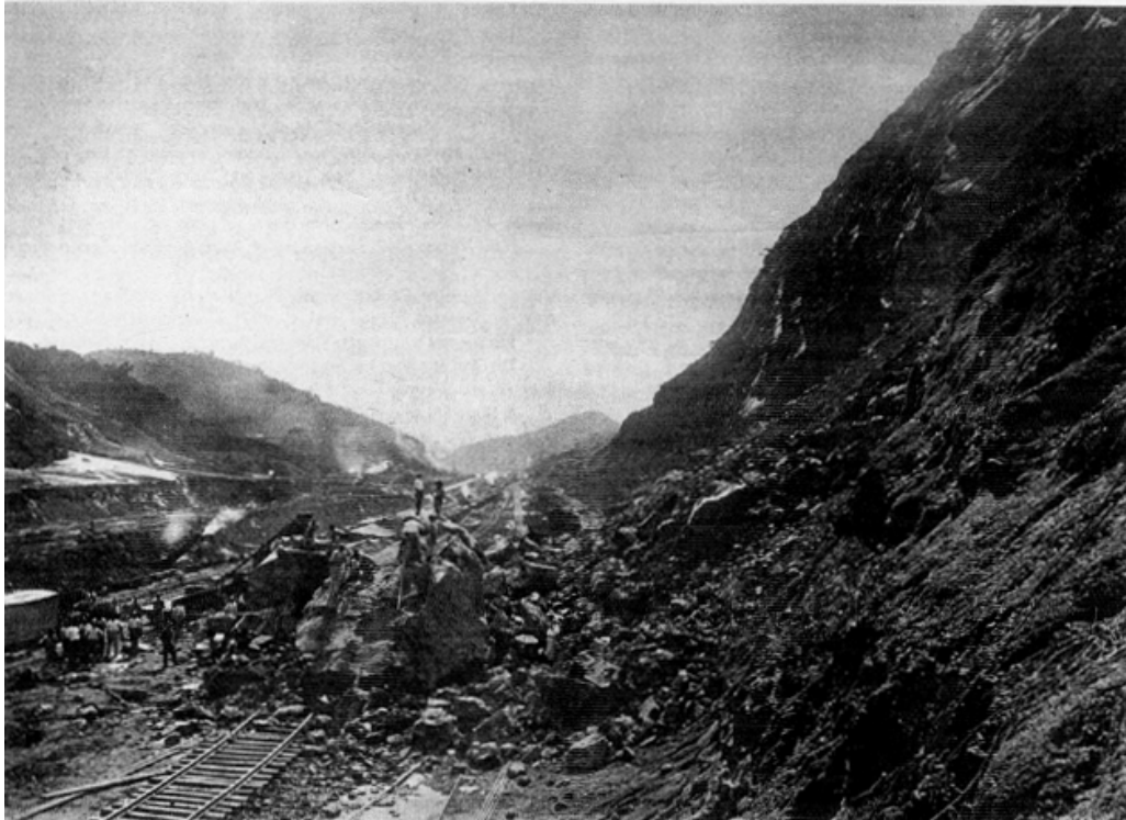
照片五 1910年11月14日發生於Cortractors Hill 因切坡而造成的順向坡岩塊滑動 (Kiersch, 1991)
