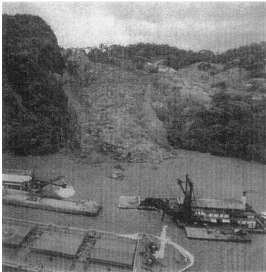
照片三 Cucaracha滑動於1986年10月復活，幾乎堵塞河道，挖泥船還在清除趾部的情形(Turner and Schuster, 1996)
