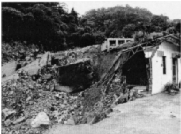
圖九 土石流流動段(輸送帶)之刷深與刷寬現象(水里鄉新山村平坑)
