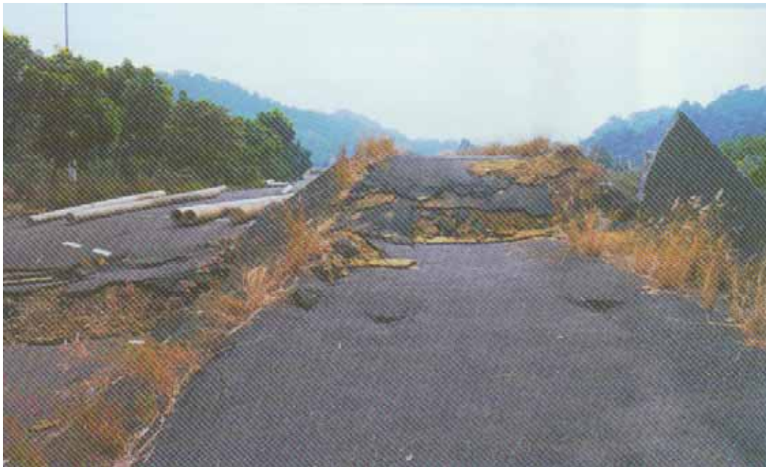
照片八 光復國中南側界外堤防道路與逆斷層交會的情形
