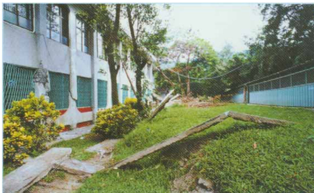
照片十六 光復國中東邊空地上混凝土版受逆斷層推動而拱起的情形
