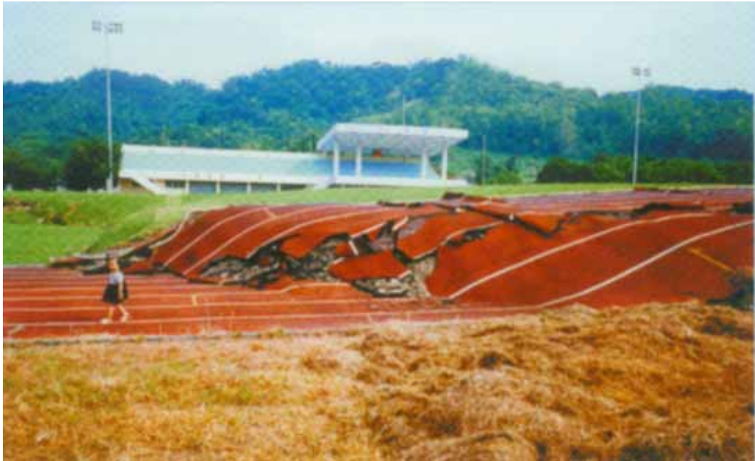
照片一 小小勘災者與大斷層，光復國中操場
