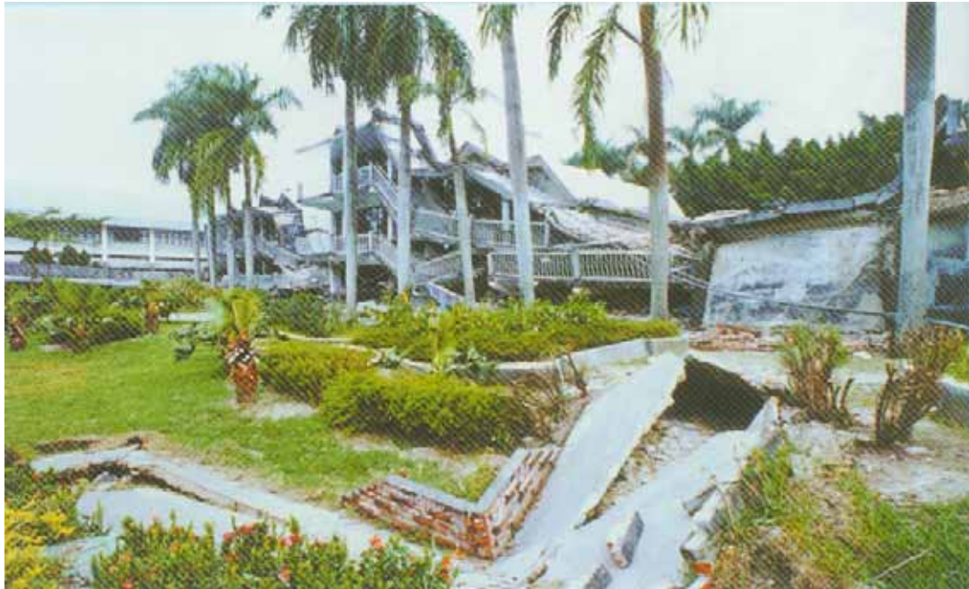
照片十一 逆斷層切過光復國中校舍之北棟建築
