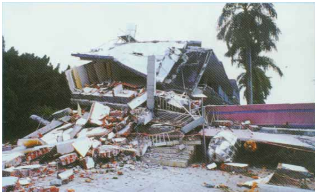
照片十五 光復國中校舍北棟建築西端倒塌的情形
