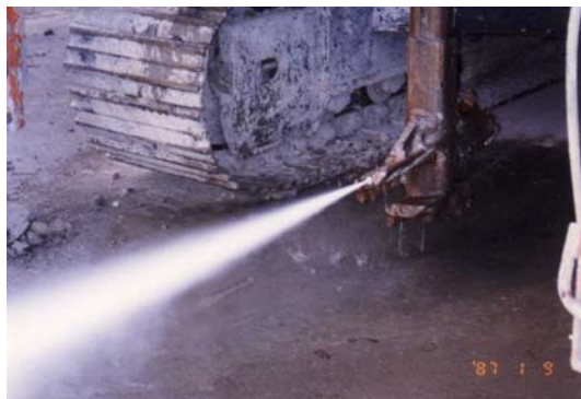
照片二 JMM工法噴嘴之噴出壓力
