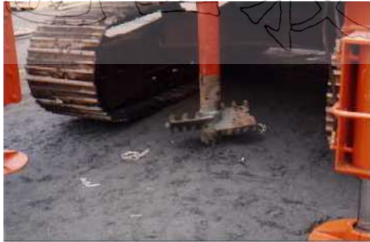
照片一 JMM工法之鑽頭與攪拌器
