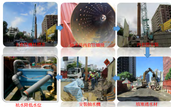
圖十二 祛水施工流程圖
