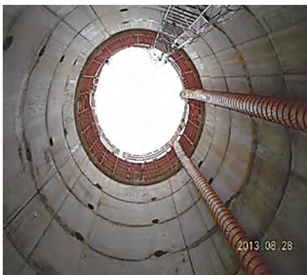
圖五 井式基礎混凝土套環澆置孔
