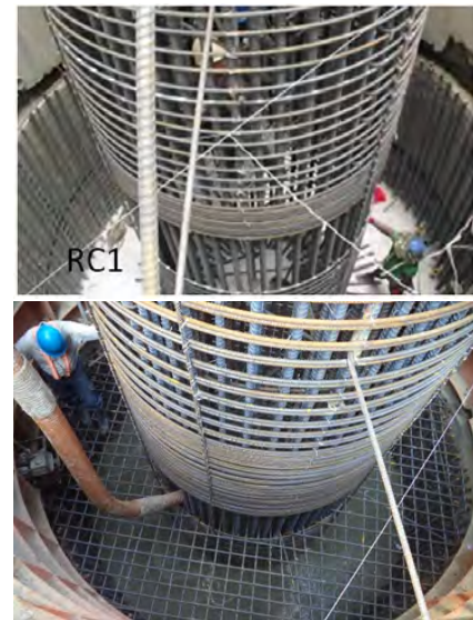
圖六 井式基礎混凝土套環澆置RC1
