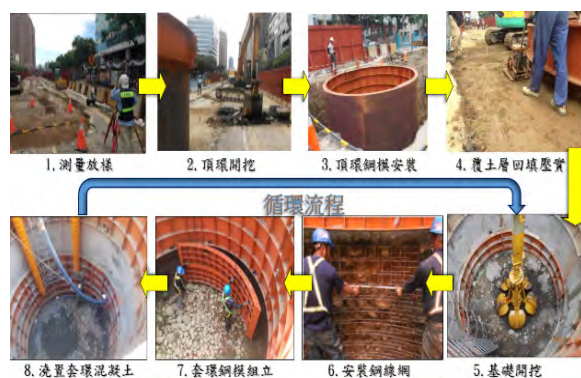
圖二 井式基礎精進工法施工流程圖
