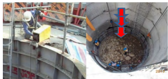
圖十三 滑模設備吊放照片
