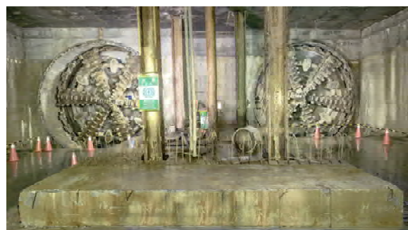
圖二十四 潛盾機上下行順利到達以棄殼方式拆解
