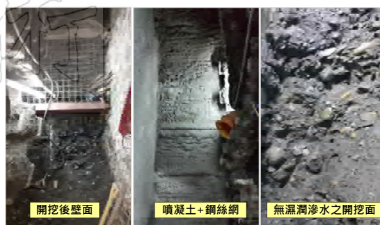
圖十五 潛盾人員出艙開挖擋土現況圖
