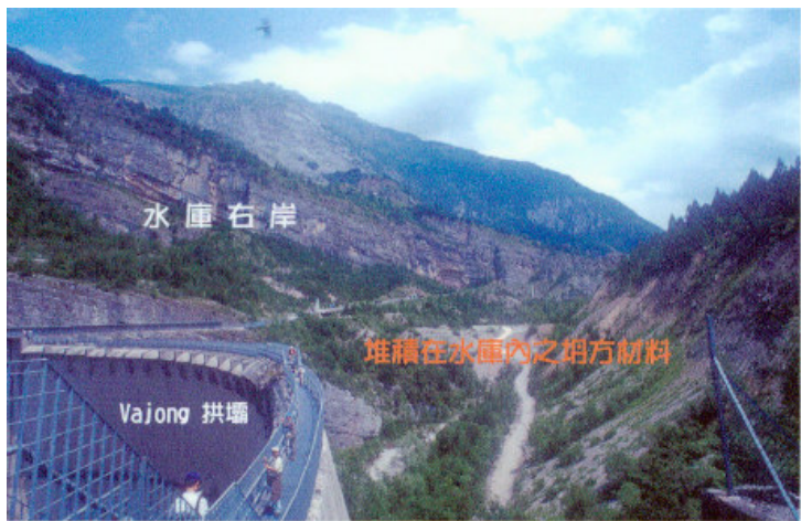
照片五 由Vajont拱壩左翼觀看壩頂、水庫右岸、與堆積在水庫內之坍方材料(洪如江攝) (照片中Vajont誤植為Vajong)
