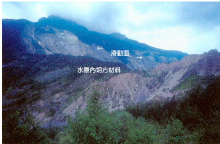
照片四 由水庫上游右岸遠眺Vajont大壩方殘坡與水庫內坍方材料(洪如江攝於民國91年7月)
