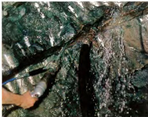
照片五 廐道內以 C 方法水刀切槽沖洗情形
