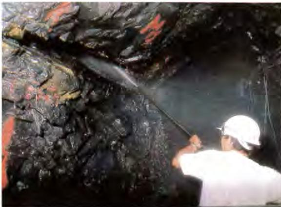
照片三 層縫處理廊道內 A 方法直式噴嘴沖洗情形
