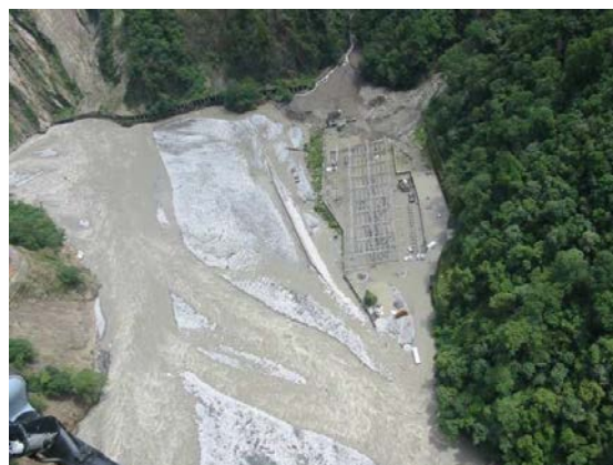
圖一 敏督利災損後青山分廠開關場區洪水損毀情形
