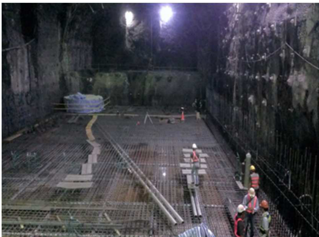
圖十四 開關場開挖完成圖
