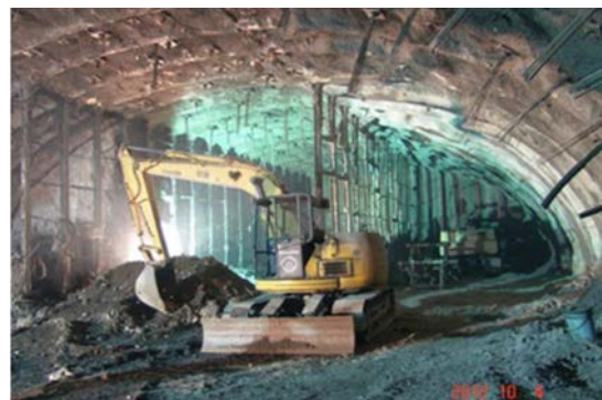
圖十 開關場頂拱開挖施工現況
