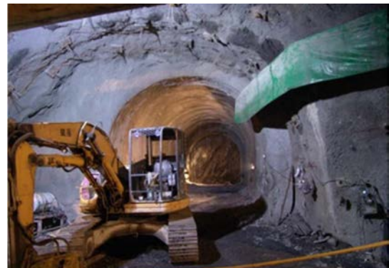
圖九 開關場施工導坑施工現況
