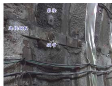
(b) 側壁補強鋼管
