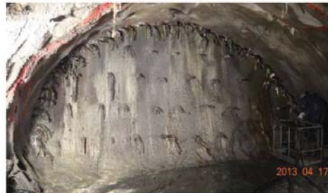
(a) 前進開挖面預加固工法
