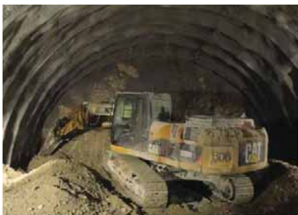
圖四十八 新山里隧道機械開挖(許等人, 2018)
