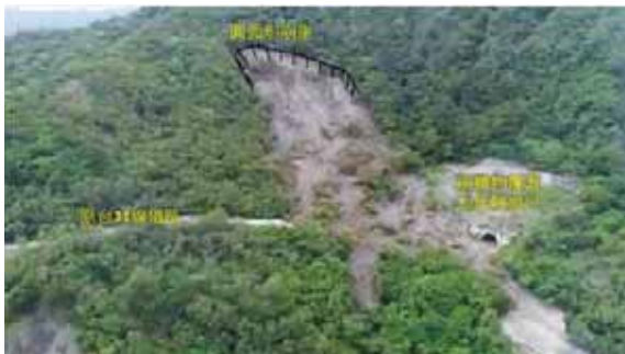
圖十 工作隧道上邊坡弧形破壞，崩積物覆蓋隧道口。位置如圖七D處 (魏倫瑋攝，2017/10/21)
