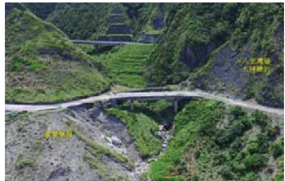
圖十二 15號橋一端建於蕃薯寮層上，經多次修補仍崩滑破損。另一端建於水璉礫上，若避開楔型滑動破壞，反較穩固。位置如圖三E處 (魏倫瑋攝，2017/10/21)
