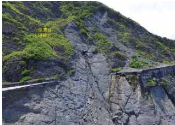
圖九 本區水璉礫岩具3組以上節理，邊坡呈楔型破壞，路段損毀嚴重。位置如圖七H處 (魏倫瑋攝，2017/10/21)
