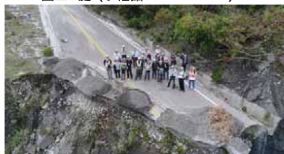
圖六 舊台11線道路崩塌處之UAV團照, 拍攝地點詳圖三D處 (魏倫瑋攝, 2017/10/21)
