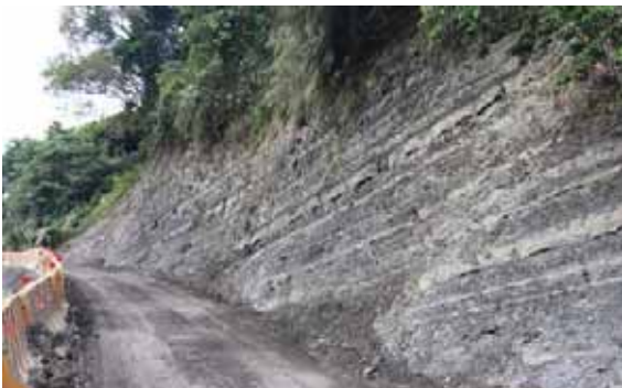
圖二十六 台23線崩塌路段出露的八里灣層露頭 (丁禕攝, 2017/10/22)
