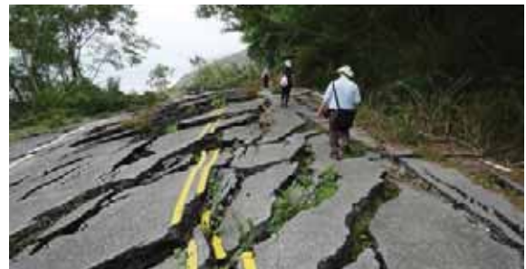
圖十三 邊坡持續崩塌使路面開裂與陷落。位置如圖七C處 (丁權攝，2017/10/21)
