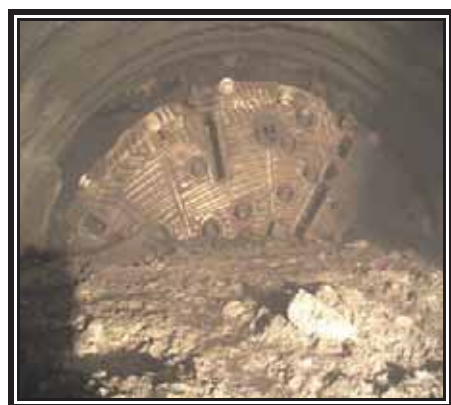
投影片 14 主坑TBM在頂帽坑下開挖
