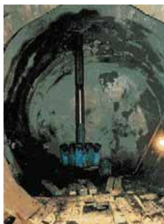
投影片4 南迴鐵路中央隧道西豎井升鑽擴孔
