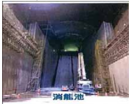
投影片 17 曾文水庫防淤隧道消能池室襯砌(摘自水利署南水局簡報)
