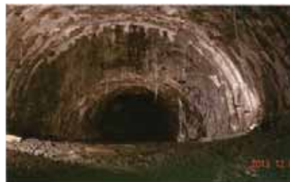
投影片 16 新自強隧道沉泥段先以中導坑貫通再擴挖(摘自地工技術No.151/2017.3)
