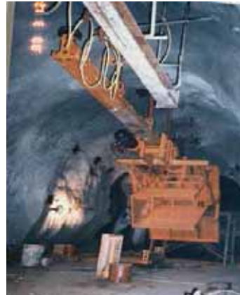
投影片7 壓力鋼管傾斜隧道導坑開挖之爬升機
