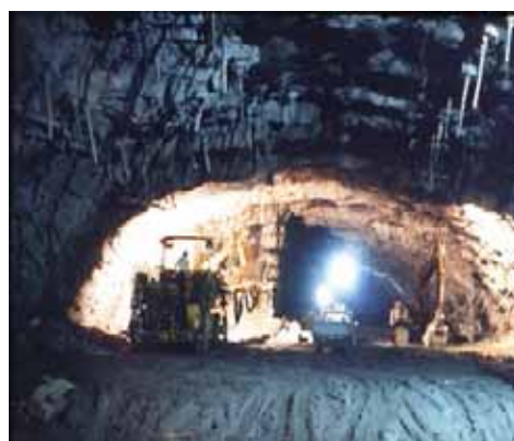
投影片6 廠房頂拱擴挖與預錨
