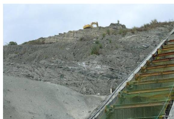
圖十 取水塔上邊坡出露砂岩及泥岩
