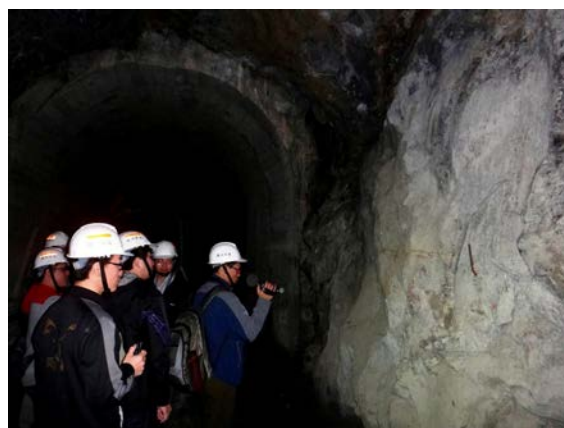
圖十一 既有多林隧道之無襯砌裸露岩盤段 (高秋振先生提供)
