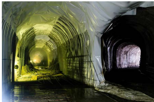
圖九 多林段新設與既有隧道交會段暨襯砌鋼筋組立(何樹根先生提供)
