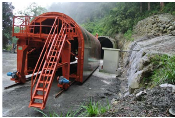
圖七 二次襯砌鋼模組立完成(進洞前)
