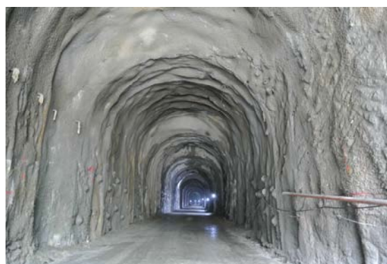
圖十 屏遮那隧道支撐完工貌
