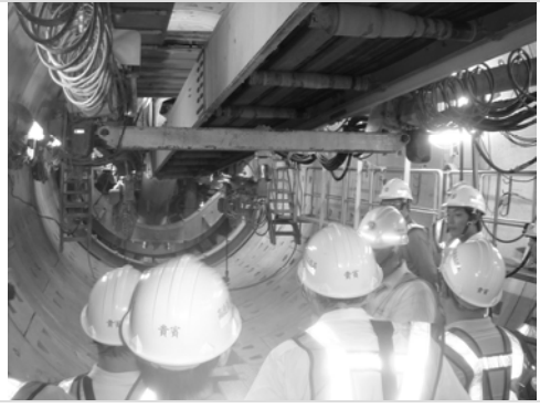
照片九 #3 隧道鑽掘施工中的潛盾機
