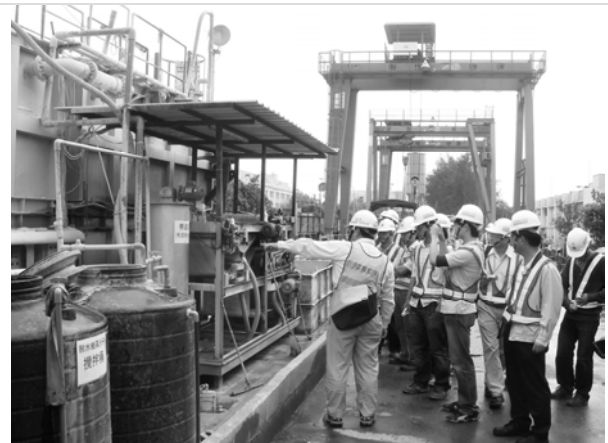
照片五 地面機電設備介紹
