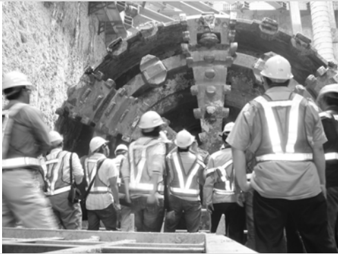
照片七 參訪者近距離檢視潛盾機掘削面盤
