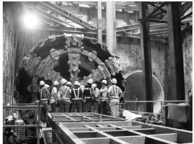
照片六 貫通#2 隧道還留在現場的潛盾機
