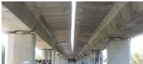
圖九 86 號快速道路 15K+200 現場橋下照片
