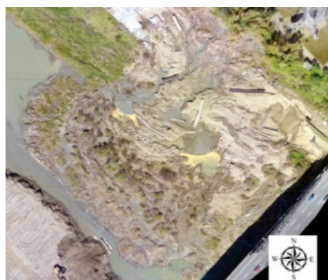
圖十四 曾文溪橋頭堤岸側潰點正射影像
