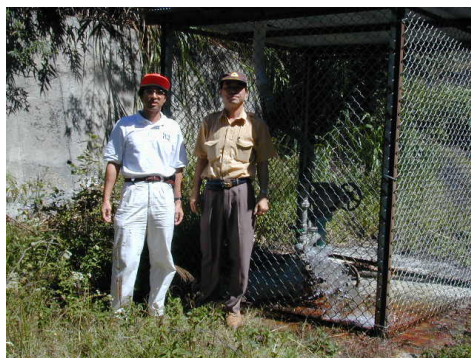
照片五 OT-1 溫泉井及井口裝置
