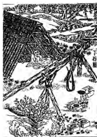
圖三 於孔口採用石製之套管以防止孔口崩塌(摘自宋應星，1637)
