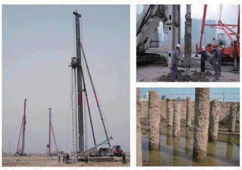
双向螺旋挤扩桩（SDS 桩）
