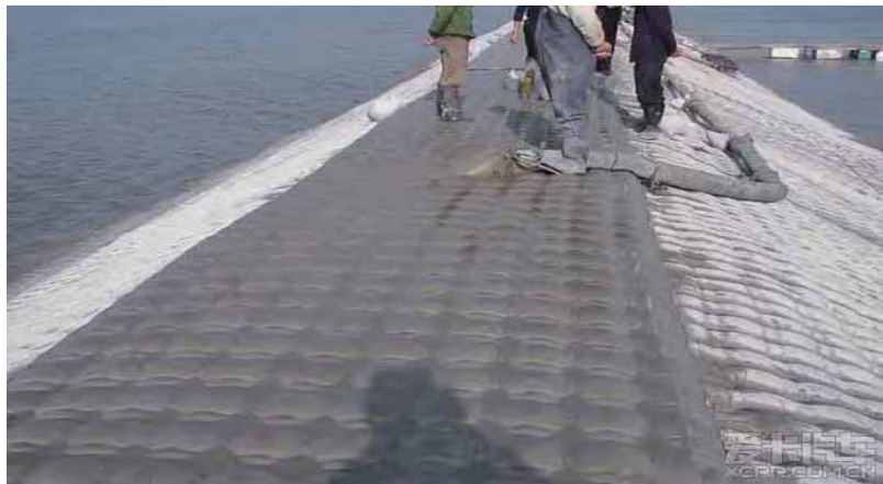
模袋混凝土围堰
