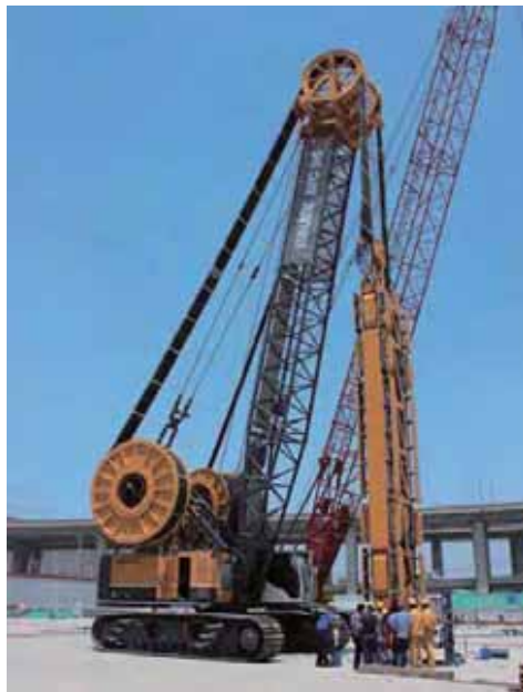
复杂地层地下连续墙技术
