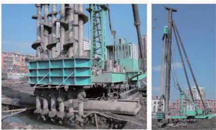
六轴水泥土搅拌桩技术
