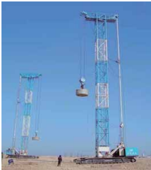
高能量级强夯地基处理技术
