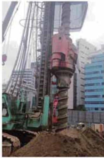
潜孔锤入岩成孔灌注桩技术
