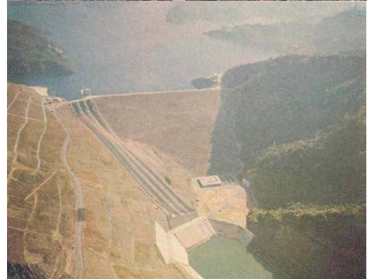
曾文水庫分階獨立瀉槽溢洪道
