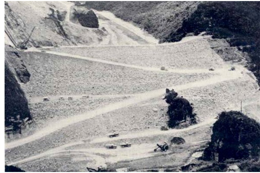
石門水庫上游擋水壩填築施工
