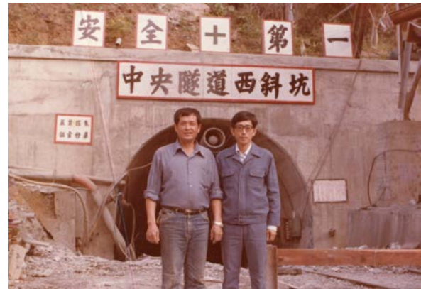
南迴鐵路中央隧道西斜坑(1985)
