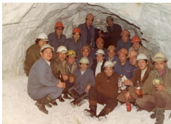
奇萊引水隧道區段貫通(1980. 3)
