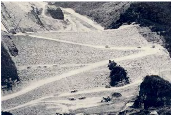
圖六 上游擋水壩填築施工中
