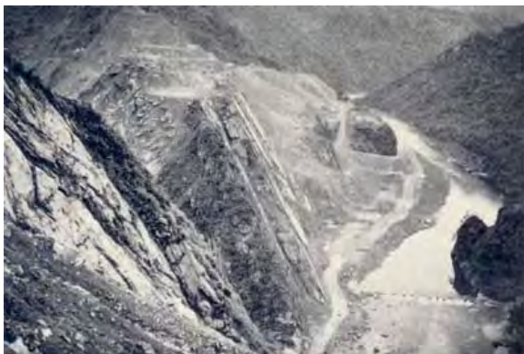
圖五 施工前上游擋水壩址地形
