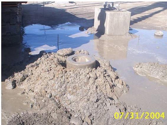
照片15 PC樁植入完成
