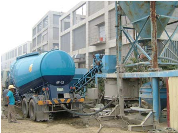
照片7 水泥槽及攪拌池
