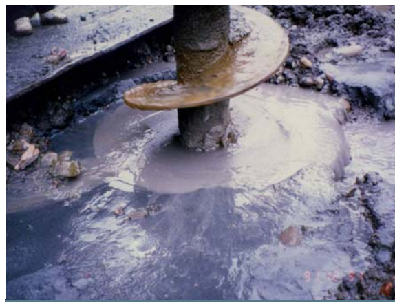
照片4 Auger鑽掘
