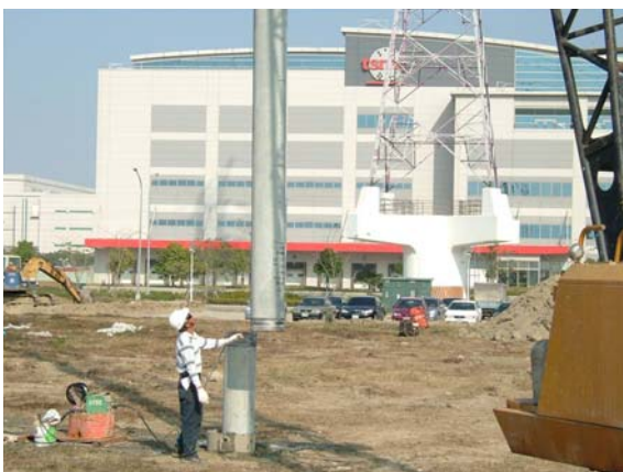
照片11 上下樁接樁
