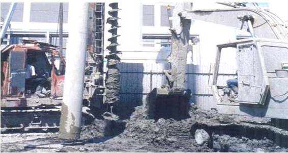
照片9 Auger拔除，準備植入PC樁
