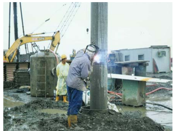
照片12 上下樁焊接
