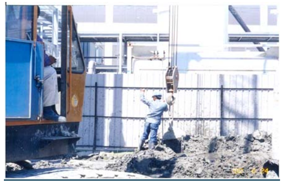
照片14 PC樁植入後吊住樁頭，防止下滑
