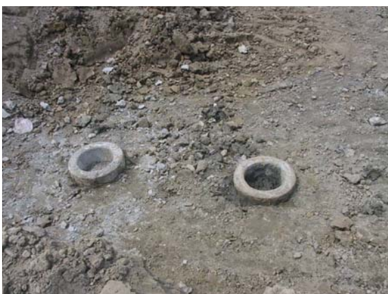
照片17 開挖基礎面，露出樁頭
