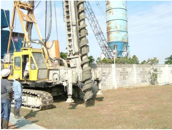
照片1 螺旋鑽機(Auger)定位準備開鑽
