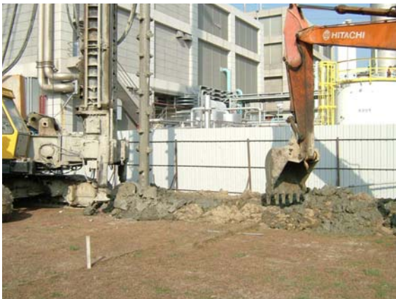
照片3 挖土機地表清除廢土及挖掘臨時迴漿池
