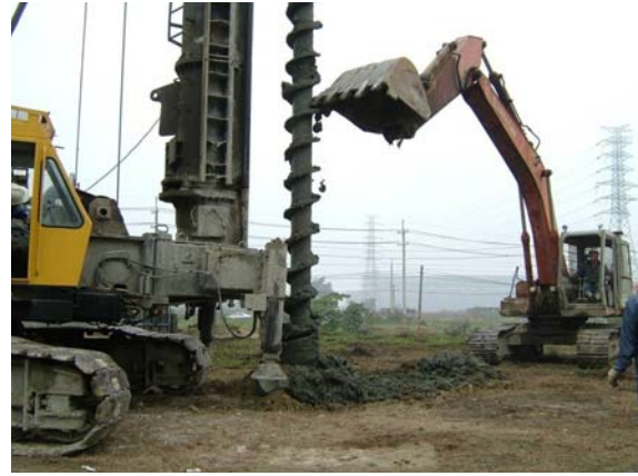
照片2 Auger正轉向上排土，挖土機配合清土
