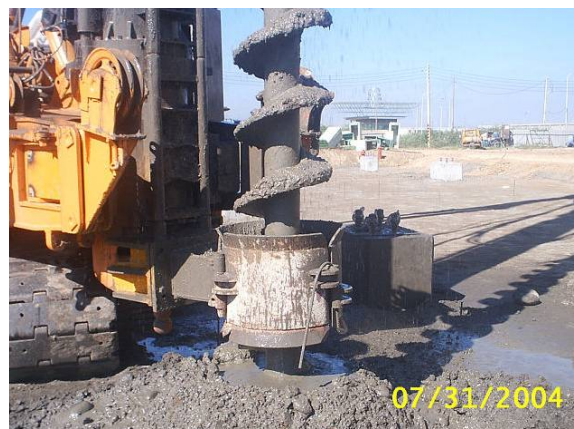
照片6 拔出鑽桿及由底部灌注固定液
