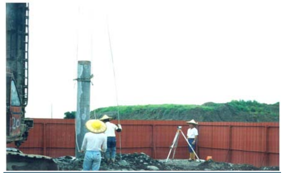
照片10 PC樁植入，測量待命
