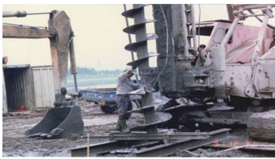
照片5 Auger上下鑽桿組裝
