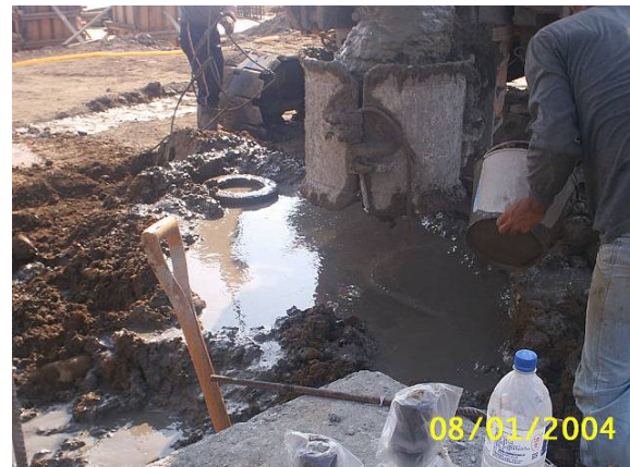
照片16 植入完成、地面補注固定液
