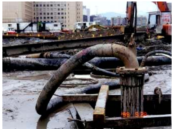
照片12 樁底第二次沉泥清除(Air-lift法)
