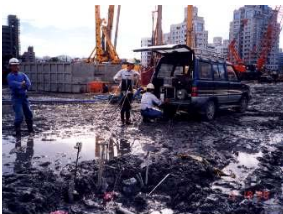
照片17 混凝土養護7日後樁體完整性檢測
