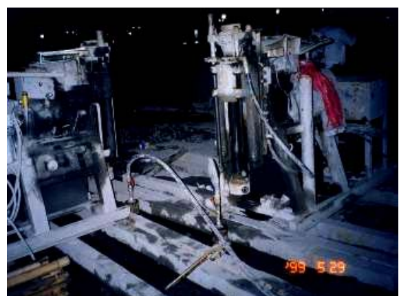
照片18 進行樁底沉泥清洗後灌漿
