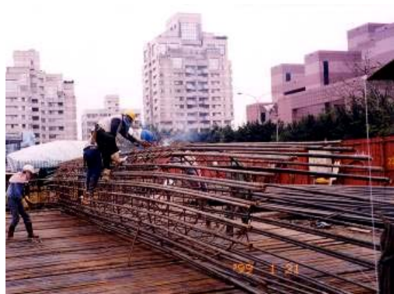
照片8 鋼筋籠製作
