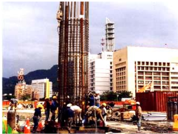
照片9 吊放鋼筋籠
