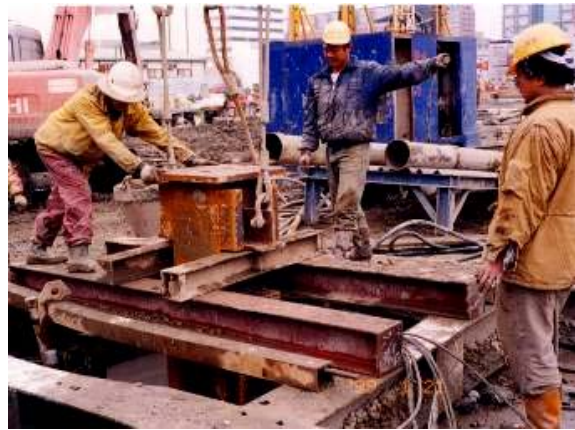
照片10 吊放逆打鋼柱(用作逆打樁時)
