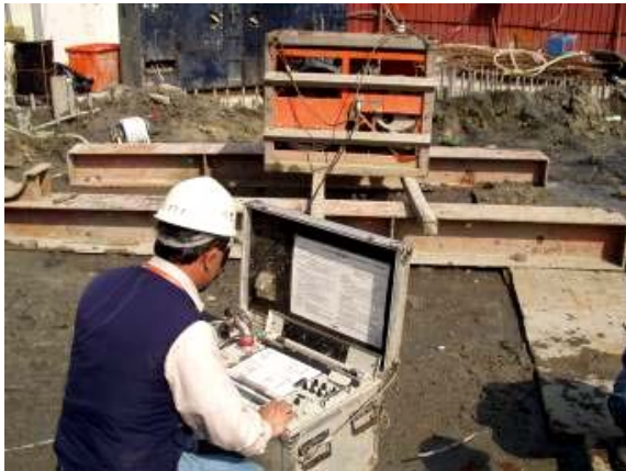
照片7 孔壁垂直度檢測
